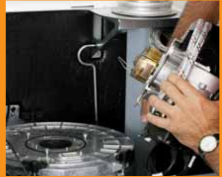
Verbrennungseinheit herausziehen
